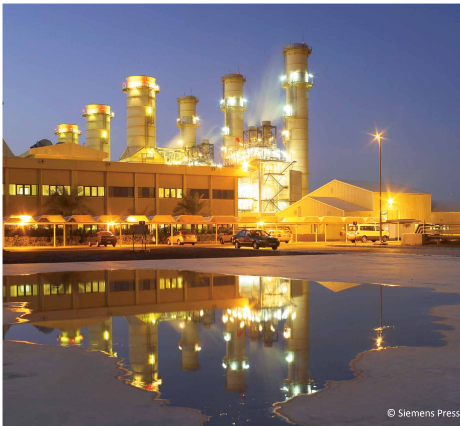
Exemple de moyen de production de pointe : une centrale thermique à cycle combiné
